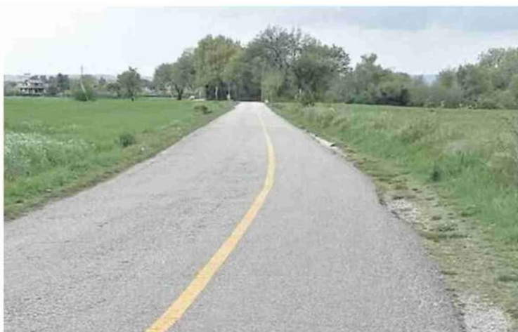
Via Ospedale delle Pareti ad Assisi, una delle zone interessate ai lavori
